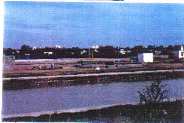
Figura 3 - 4: Construcción de la nueva planta de tratamiento.
